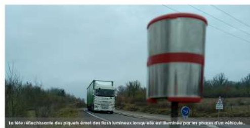
La tête réfléchissante des piquets émet des flash lumineux lorsqu'elle est illuminée par les phares d'un véhicule.
